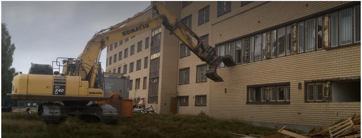
Kuva 5: Irrotusta kaivinkoneella ja purkukouralla
