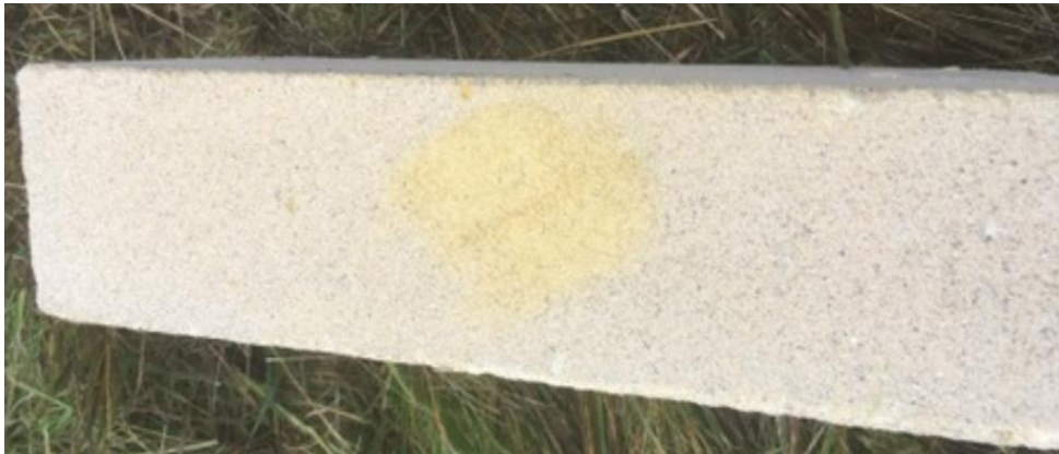
Kuva 14: Tiilen ulkopinta oli kevyesti rapautunut
