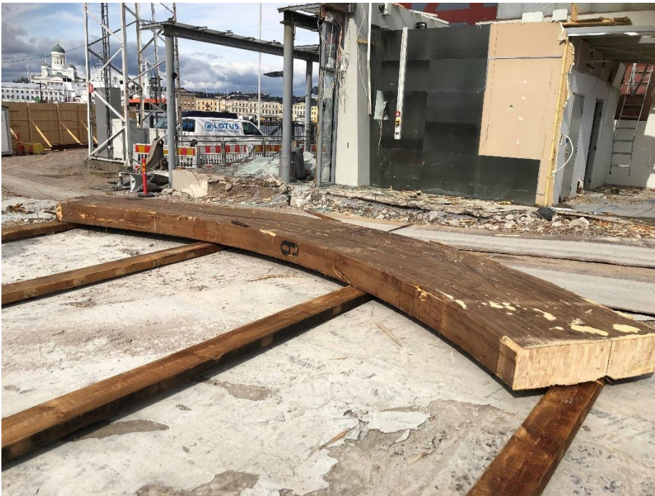
Kuva 4. Liimapuupalkki Helsingin satamaterminaalien purkukohteesta.
