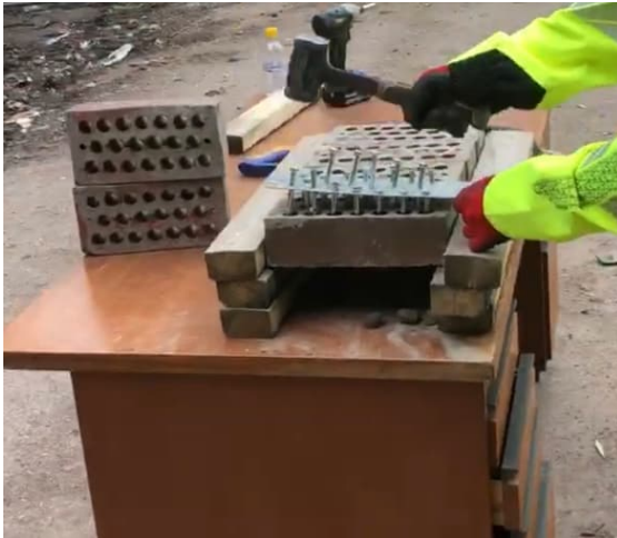
Kuva 4: Tiilen reikien puhdistus omavalmisteisella työkalulla
