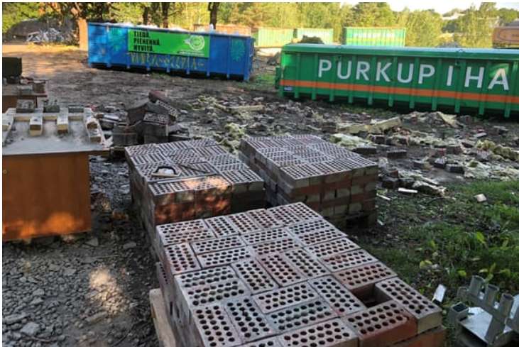
Kuva 3: Puhdistettuja tiiliä pakattuna
