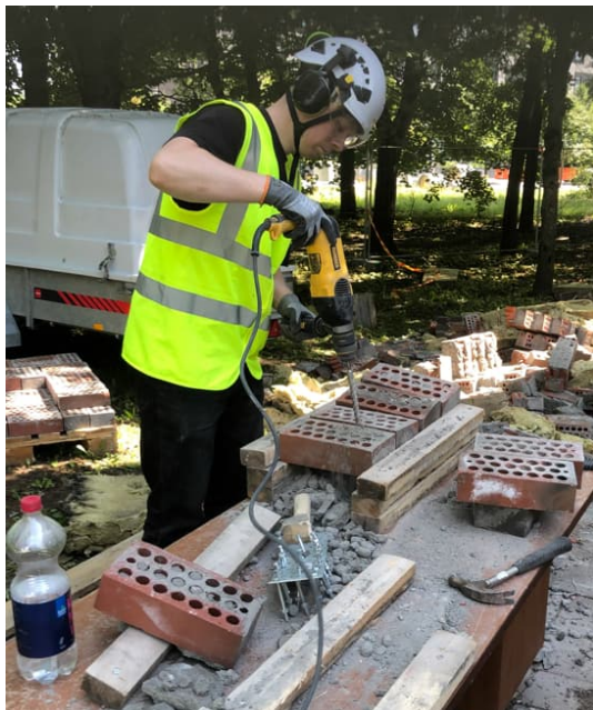
Kuva 6: Tiilen puhdistusta porakoneella
