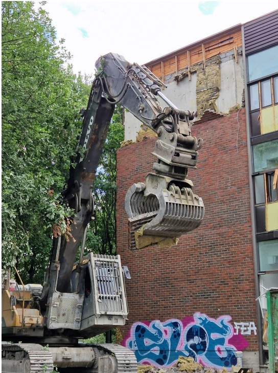
Kuva 2 Koeirrotuksen seinärakenne ja ensimmäisen purun kappaleita
