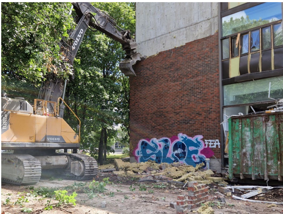
Kuva 1, Kytösuontie 9-11 tiilien koneellinen purku
