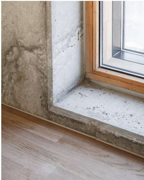
Kuva 10 Lasituksissa on kaksi eristyslaselementtiä rinnakkain ja lasien välissä on ilmarako. Kokonaisuudella on hyvät lämmöneristysominaisuudet. Kuva: Lendager Group
