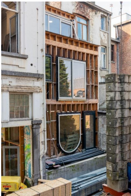
Kuva 1 Masui4Ever second-hand-ikkunat asennettuna julkisivurunkoon. Kuva: Delphine Mathy 2021.
