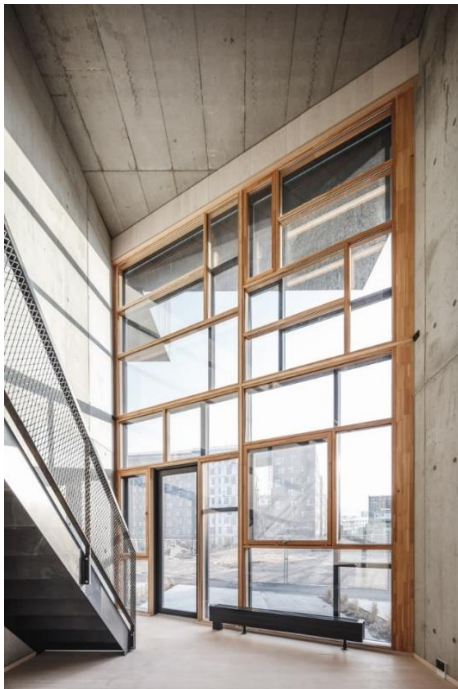
Kuva 9 Julkisivulasituksen sisä- ja ulkopuoli on lasitettu erikseen, mikä on antanut joustavuutta käytettävissä olleiden ikkunoiden mukaan. Sisä- ja ulkopuolien puukehykset ovat eri väriset. Kuva: Lendager Group
