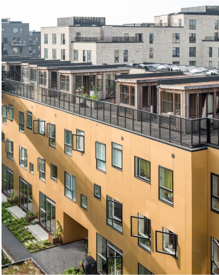
Kuva 7 Puutarhamökkejä toisen Resource Rows-rakennuksen rakennuksen katolla. Kuva: Lendager Group
