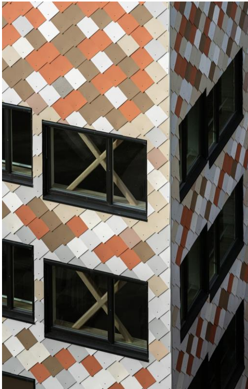
Kuva 5 Erikoiset suojakaiderakenteet estävät putoamisen matalimmalle asettuvista suurista ikkunoista. Samanlainen muoto toistuu muualla rakennuksen sisällä. Kuva: Mad Arkitekter
