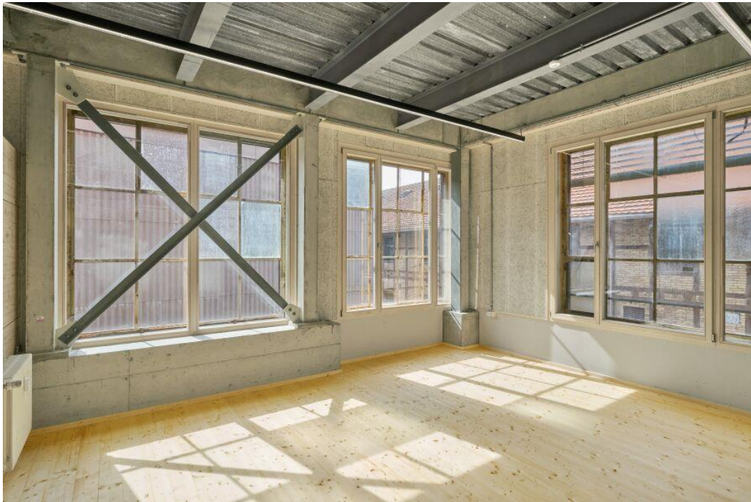
Kuva 13 Vanhat teollisuusikkunat pitävät julkisivun ilmeen ennallaan. Sisäpuolelle on asennettu modernit eristyslasi-ikkunat. Kuva: Baubüro In Situ ag
