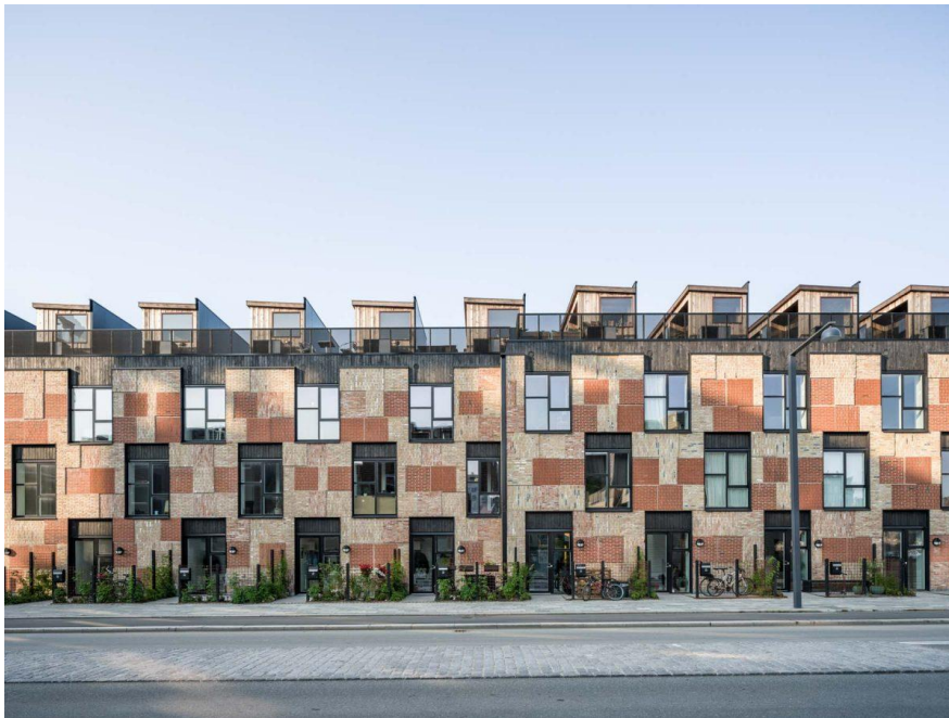
Kuva 6 Resource Rows tiilijulkisivu. Katoilla puutarhamökit, jotka on rakennettu second-hand-materiaaleista. Kuva: Lendager Group
