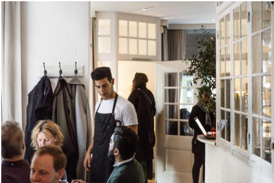
Kuva 20 Ravintolan sisätilojen lasirakenteita vanhoista puuikkunoista. Kuva: Genbyg.dk
