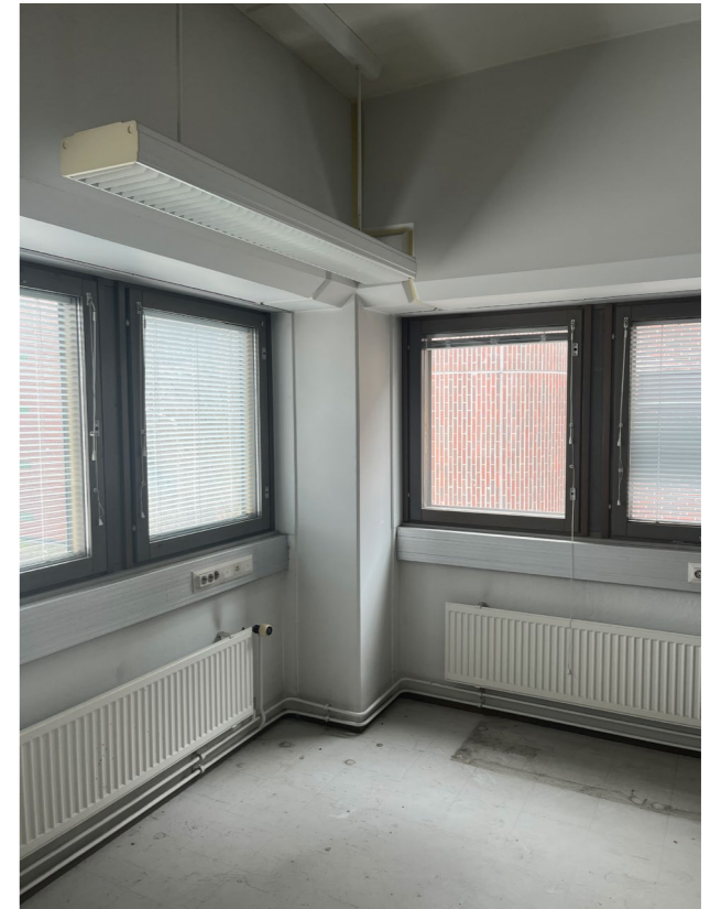
Toimistosiipeen betonielementtirunkoa ja julkisivuelementtejä ikkunoineen.
