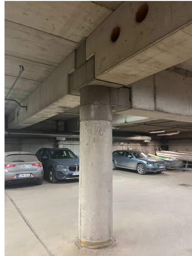
1980-luvun kellarin rakenteita: Elementoidut palkit, pilarit ja liitoskohdat saumoineen näkyvissä.
