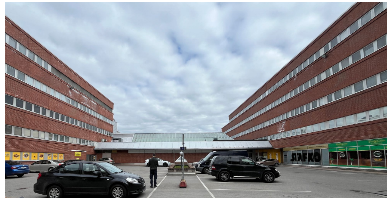
Näkymä rakennuksen sisäpihalta toimistosiipeen välistä.
