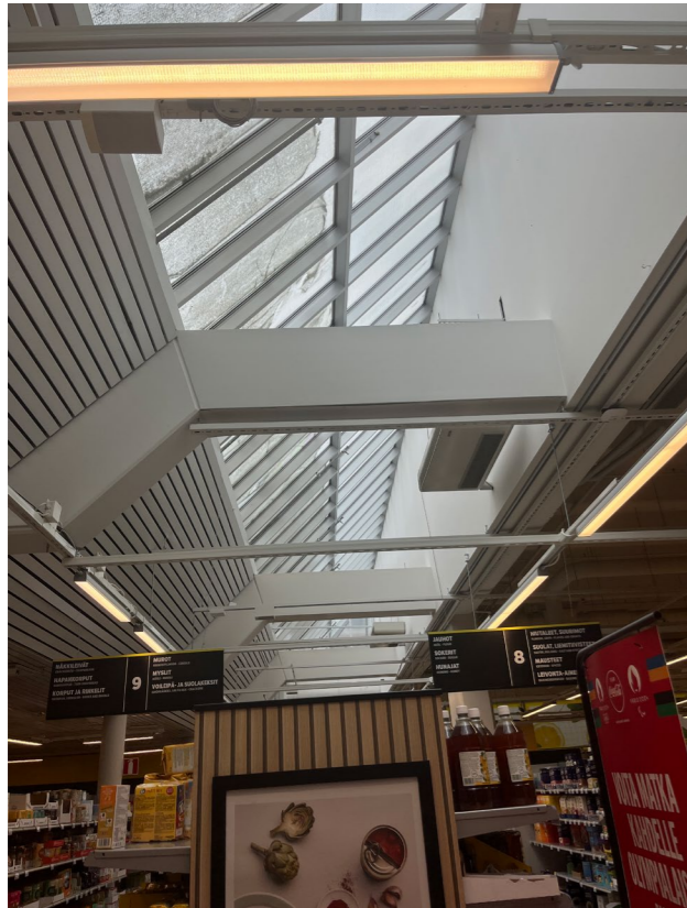
Marketin kattorakenteita, oletettavasti paikalla valettuja betonirakenteita.
