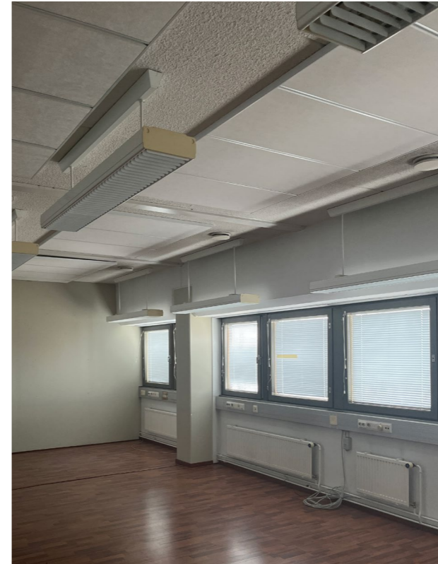
Tyypillinen toimistotila ylemmissä kerroksissa
