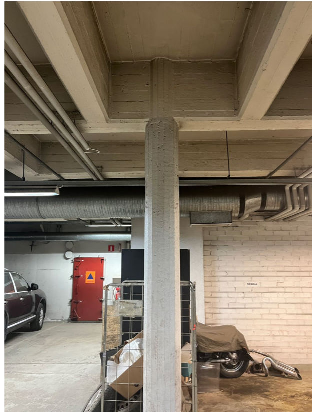
Oletettavasti alkuperäisiä kellarin kattorakenteita 1960-luvulta, paikalla valettuja betonirakenteita.
