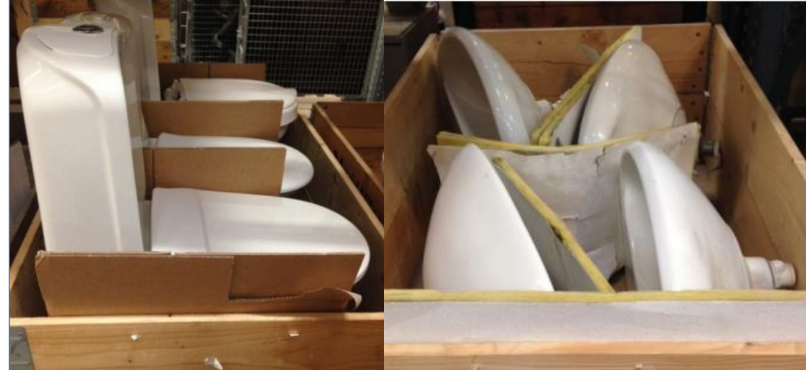
Kuva: WC-istuimet ja pesualtaat pakataan esimerkiksi eurolavoille käyttäen kiinnitykseen samoja reikiä kuin millä kalusteet ovat olleet kiinnitettynä käytössä ollessaan. Lähde: CCBUILD
