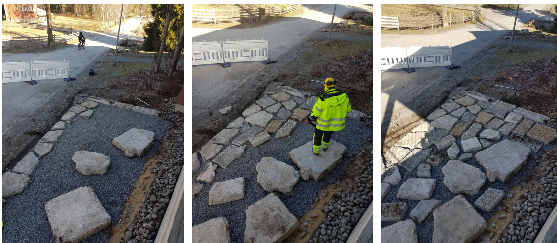
Kuva 2. Betonielementtien asennus (Loci maisema-arkkitehdit Oy).
