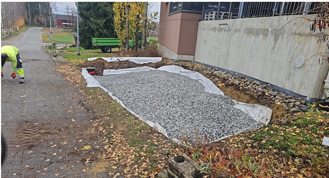
Kuva 1. Pilottikohteen valmis pohjarakenne (Kaisa Koskelin / AhlmanEdu).
