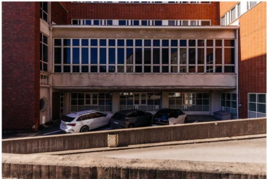
Sturenkatu 16 "leipomon alueen" osittain säilyvää julkisivua Elimäenkadulle
