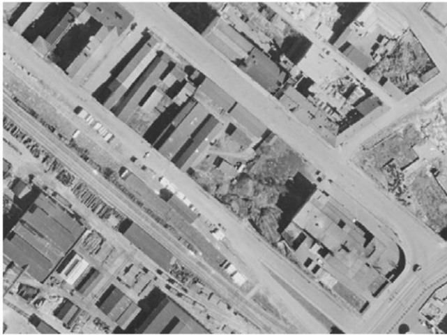
1943. Korttelissa lautatarhan rakennuksia ja leipomo, jota laajennettu 1937.
