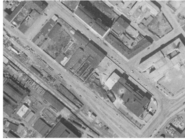
1956. Pieniä muutoksia lautatarhassa, leipomoa laajennettu uudestaan 1949.
