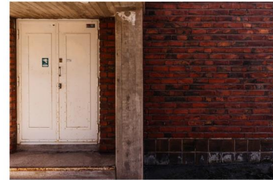
Sturenkatu 16 "leipomon alueen" osittain säilyvää julkisivua Elimäenkadulle
