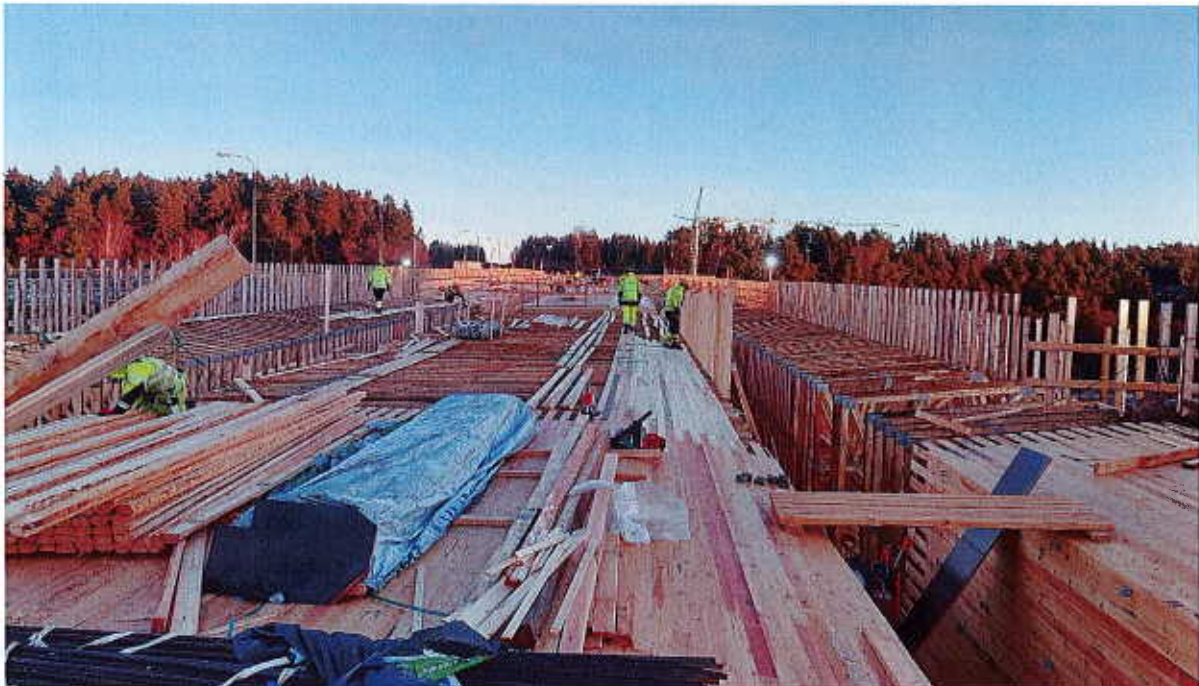
Kuva 2. Suurten maantiesiltojen ja rautatiesiltojen rakentaminen vaatii merkittäviä määriä puutavaraa tukirakenteisiin, muotteihin ja väliaikaisiin rakenteisiin.
